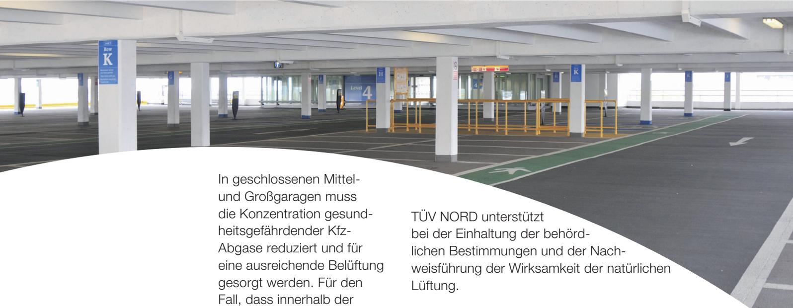
In geschlossenen Mittel- und Großgaragen muss die Konzentration gesundheitsgefährdender Kfz-Abgase reduziert und für eine ausreichende Belüftung gesorgt werden. Für den Fall, dass innerhalb der Garage die baulichen Voraussetzungen für eine natürliche Lüftung gegeben sind, kann auf eine maschinelle Lüftungsanlage mit Ventilatoren verzichtet werden.
